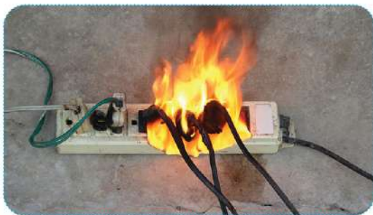
Nguồn nhiệt do điện chập mạch, quá tải (do cắm nhiều thiết bị công suất lớn vào cùng một ổ cắm)
